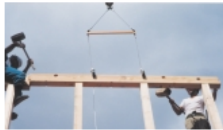
木質梁の吊り上げ
